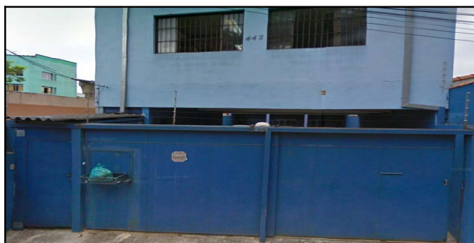
Rua Santa Luzia nº 443, Vila Santa Luzia
